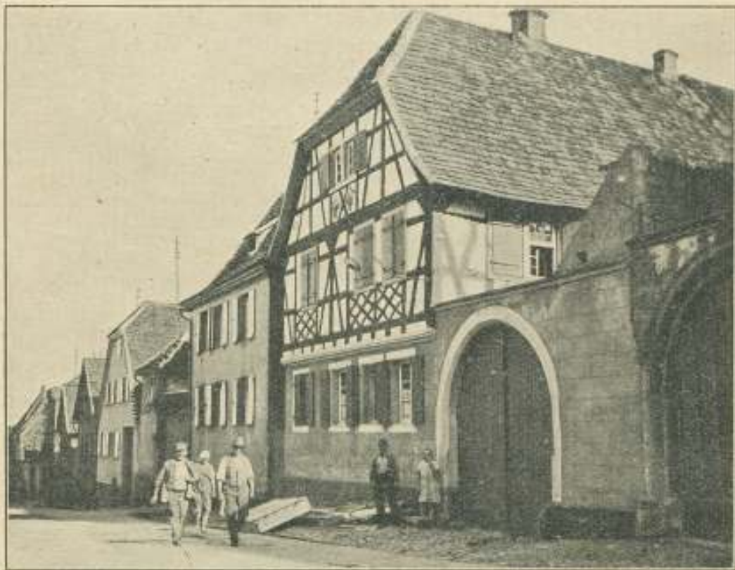
Theresienstraße Haus Nr. 43, Altes Fachwerkbau
